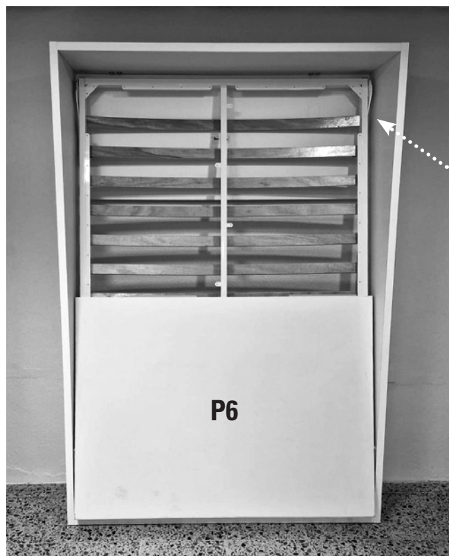
9 POSITIONNER LE CADRE DE L'ARMOIRE-LIT COMME SUR L'IMAGE VERS L'INTÉRIEUR DE LA STRUCTURE
