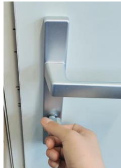
Verrouillage par volant à main
